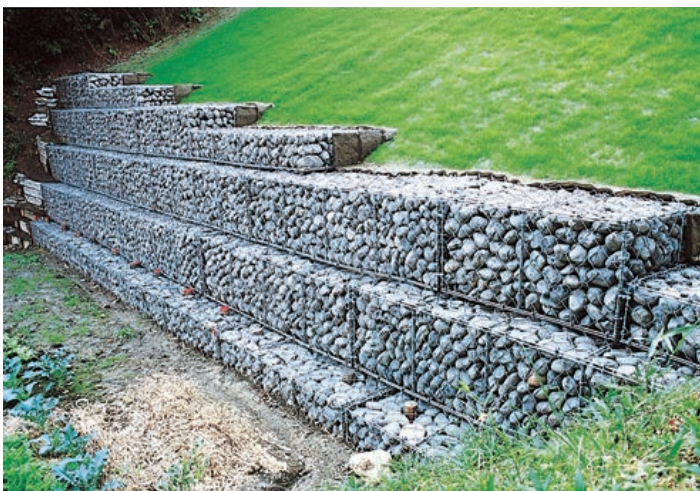
▲ 地すべり防止工事
