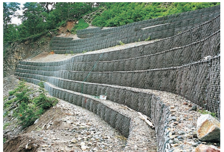
▲ 地すべり防止工事
